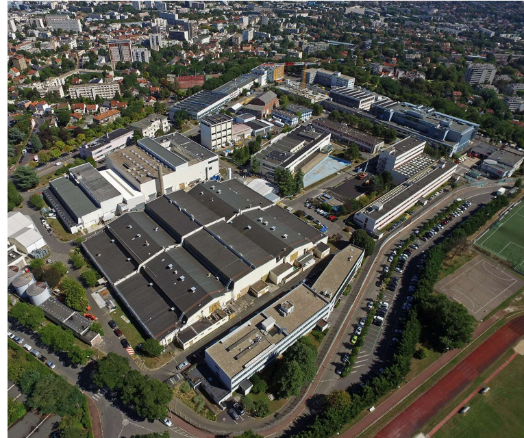
Vue aérienne du CEA/Fontenay-aux-Roses.
