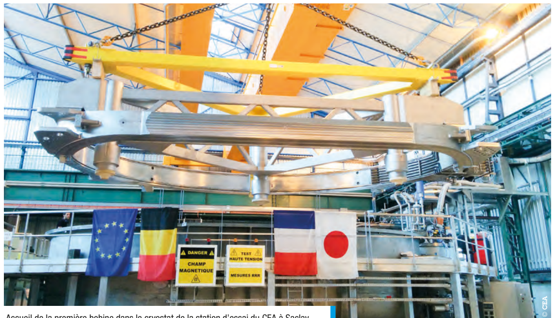
Accueil de la première bobine dans le cryostat de la station d'essai du CEA à Saclay.
