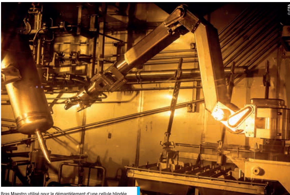
Bras Maestro utilisé pour le démantèlement d'une cellule blindée.
