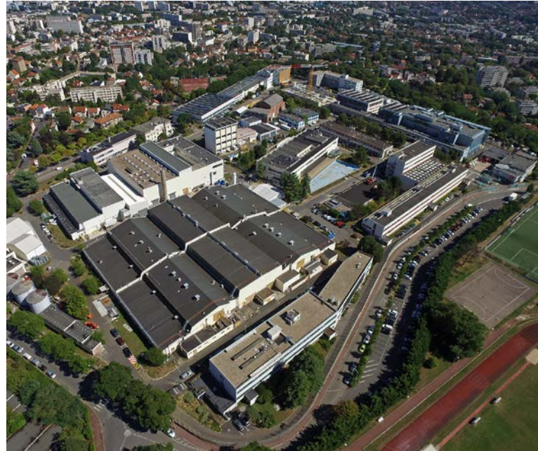
Vue aérienne du CEA/Fontenay-aux-Roses.
