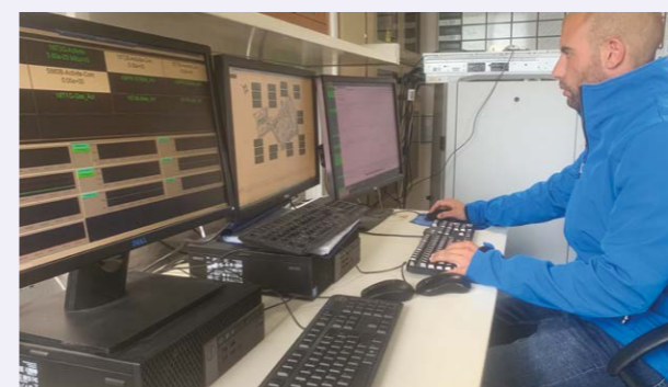
Suivi des mesures en continu sur le tableau de contrôle de l'environnement.
