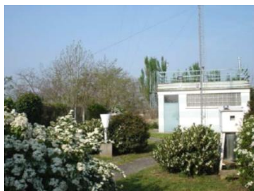
Station de surveillance de l'environnement
