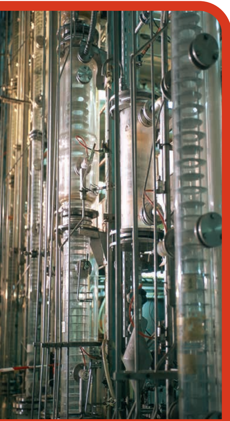
Colonnes pulsées en cours de démantèlement en 2004 à Fontenay-aux-Roses. Elles ont servi à la mise au point du procédé de retraitement des combustibles usés en exploitation à la Hague (bâtiment 91, Fontenay-aux-Roses).
