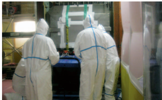
Éole : extraction, à l'aide d'un palan, de la chaîne blindée nécessaire au démantèlement (vue à travers la paroi de l'enceinte de confinement).
