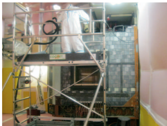
Eole : vues de la chaîne blindée en cours de démantèlement.
