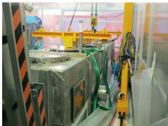
Gascogne : chaîne blindée en cours de démantèlement, enceinte G1 sur palette.
