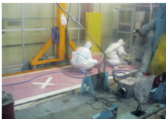
Guyenne : repli de chantier après démontage de la chaîne blindée.
