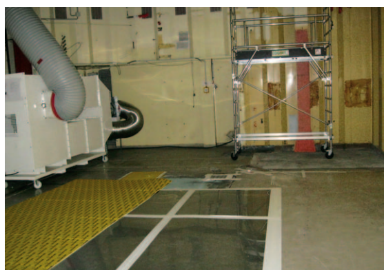
2 - Éole : emplacement après démantèlement - 2011.
