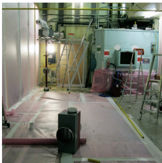
1 - Éole : préparation du chantier de démantèlement de la chaîne blindée - 2011.
