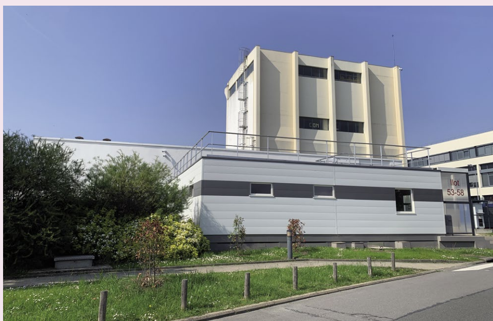
Les travaux se sont poursuivis bâtiment 53 ©CEA/C. Perrin
