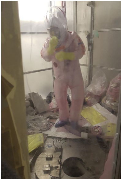
Les travaux bâtiment 18 salle 112 ©CEA/S. Renard
